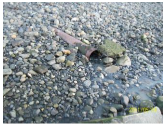
Descarga sector Ukika
