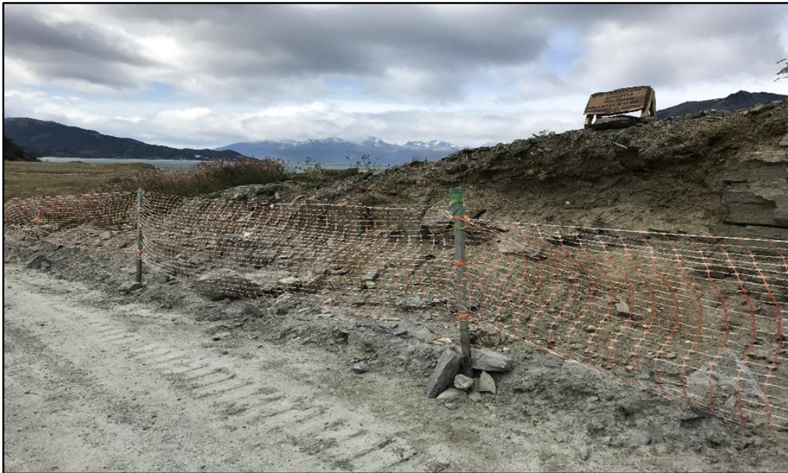
Instalación de cercado y señalética para protección de sitios arqueológicos vinculados a la obra, Proyecto Camino Estancia Vicuña Yendegaia, Región de Magallanes y la Antártica chilena.
