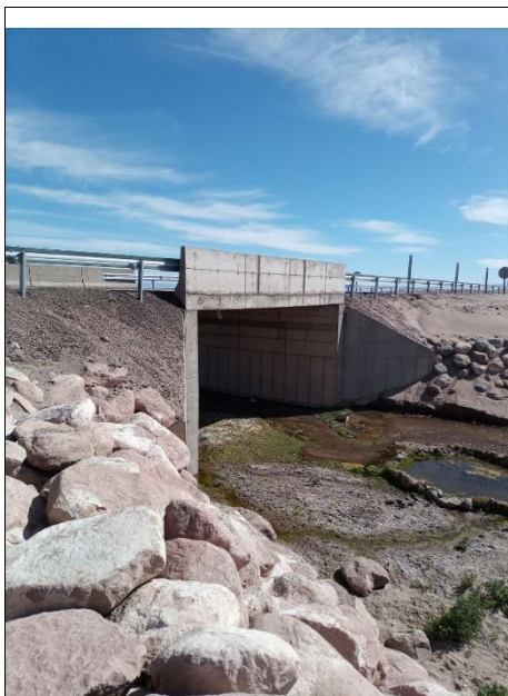
Puente de Losa existente en ruta 23-CH.
